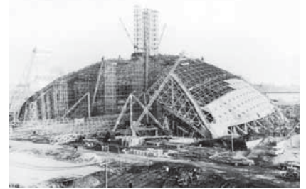
建設途上の国際貿易センター2号館
