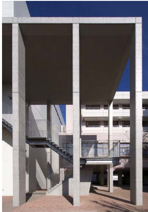
外部階段/プロムナードに面する折り返し階段は、スパン約12mを有し、既存建物間との庇を兼用している。
