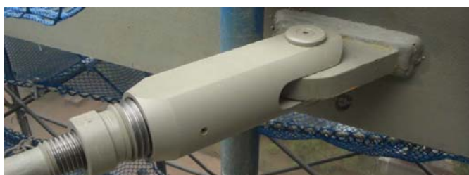
ステイロッドと外周梁接合部
