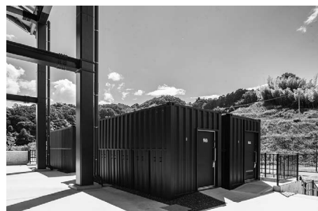
コンテナトイレ
