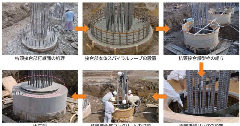
杭頭接合部打継面の処理
